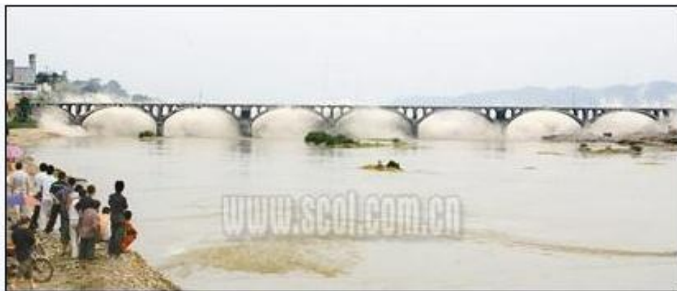
大桥岿然耸立，桥墩完好，桥拱和桥面都好好的。
